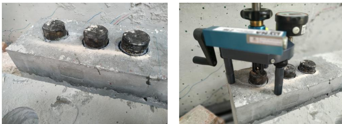
Figura 3.17-Ensaio de arrancamento realizado numa viga reforçada com UHPFRC
