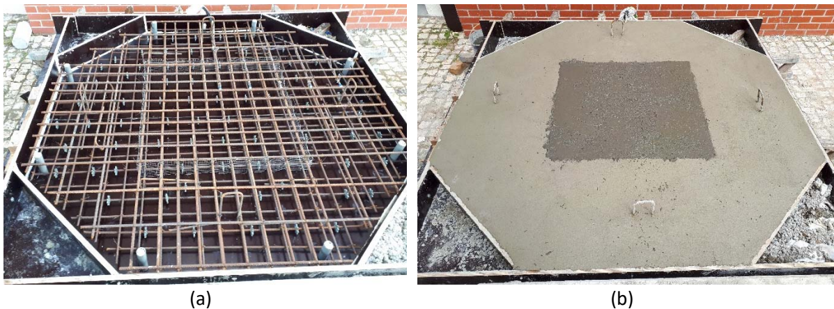
Figura 3. Betonagem dos modelos: a) Armaduras, cofragem e malha de aço galvanizado; b) laje acabada.
