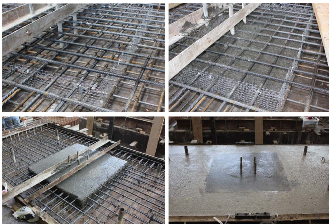
Figura 5 – Fotos da betonagem do modelo CSHC2.
