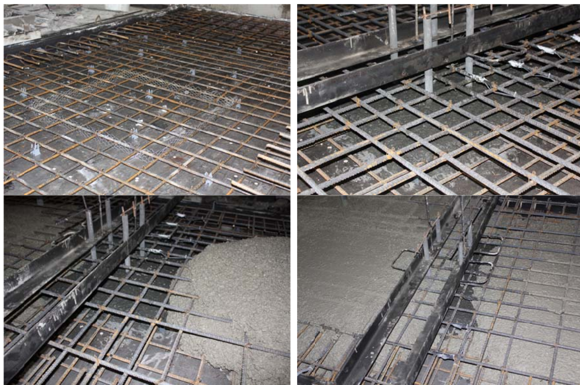
Figura 4 – Fotos da betonagem do modelo SHSC1.
