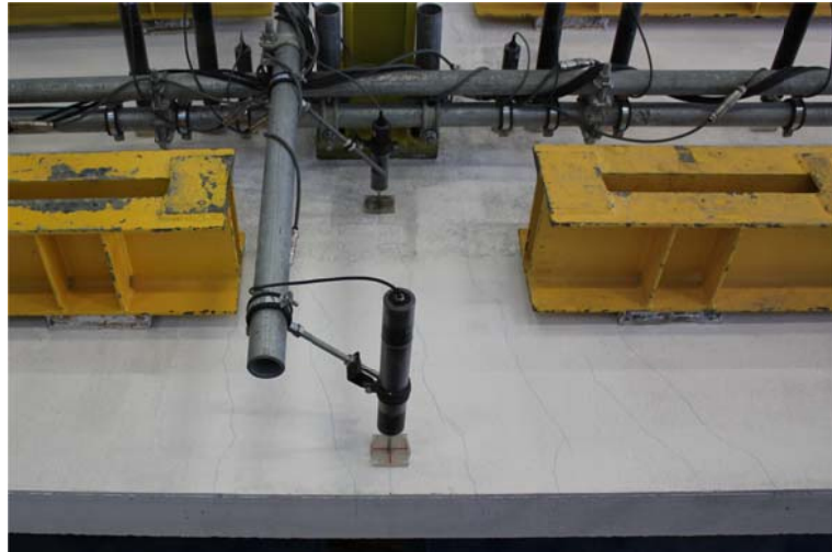
Figura 26 – Distribuição da fendilhação de flexão na face superior do modelo SHSC3 após a aplicação do carregamento vertical.
