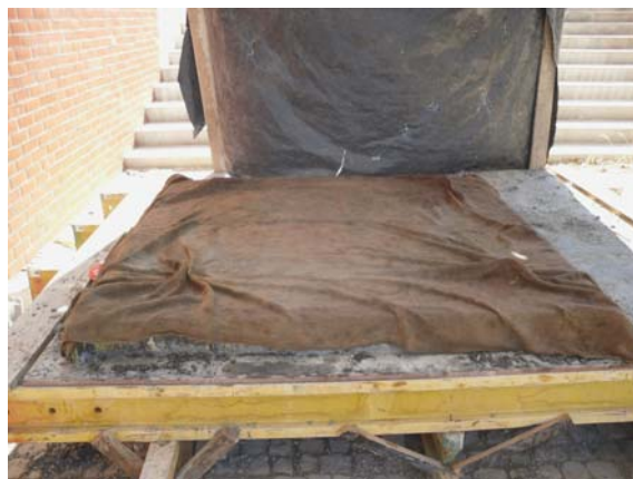
Figura 4 – Laje após betonagem, coberta com manta de serapilheira humedecida.
