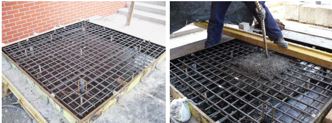
Figura 3 – Vista geral do molde e armadura (a) e betonagem (b).
