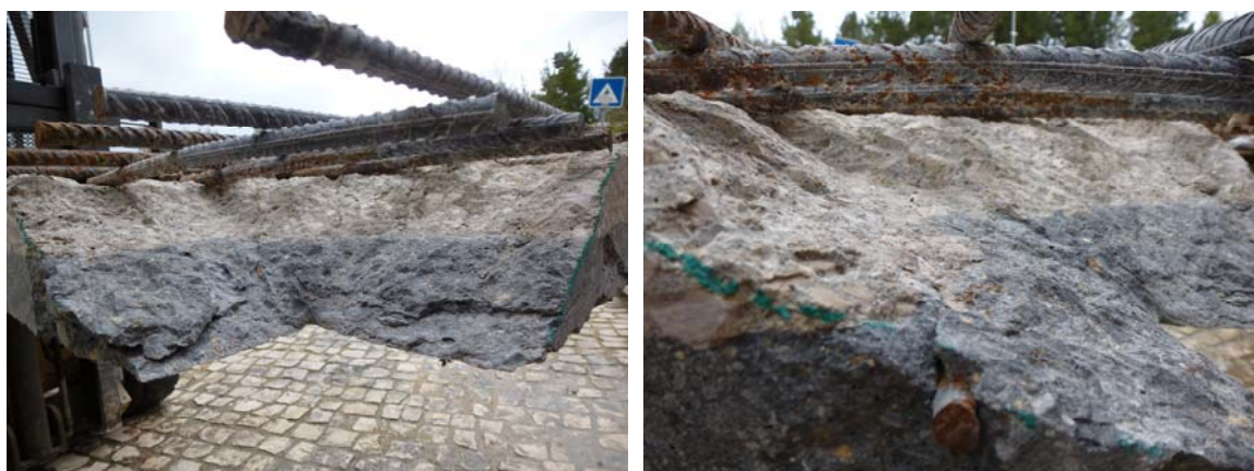
Figura 25 – Detalhes da superfície de rotura do modelo SHSC5.
