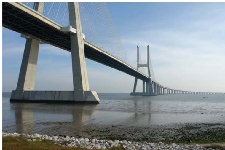
Figura 6 – Ponte Vasco da Gama [31].
