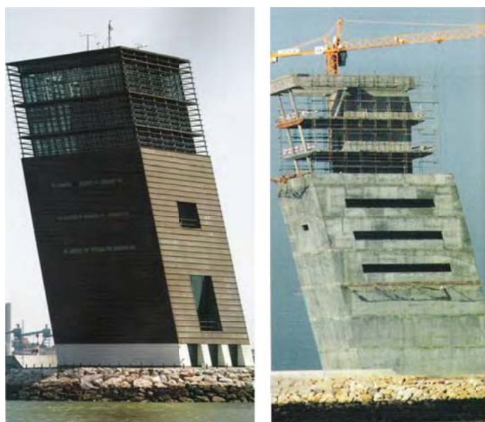
Figura 7 – Edifício do Centro de Coordenação e Controlo de Tráfego do Porto de Lisboa
