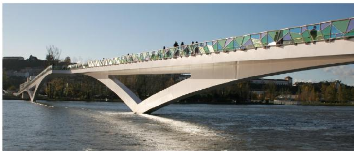
Figura 5.7: Vista geral da ponte Pedro e Inês, Coimbra, Portugal [16]
