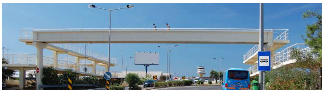
Figura 5.1: Vista panorâmica do passadiço pedonal em estudo.
