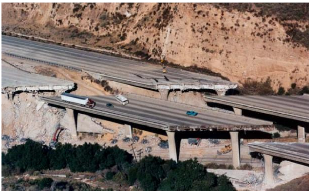
Figura 1.2: Viaduto de Gavin Canyon, sismo de Northridge, 1994 [50].
