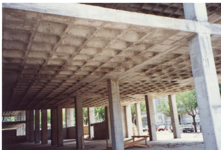
Fig. 1 - Edifício com estrutura de lajes fungiformes sem paredes resistentes nem pórticos na periferia.
