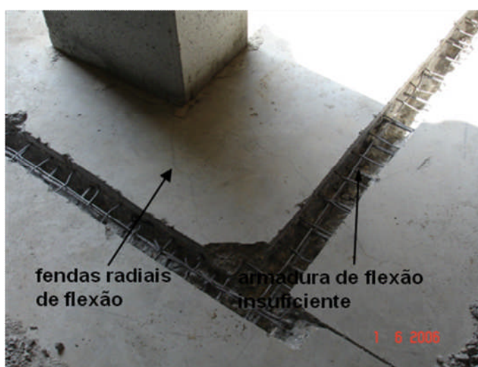
Fig. 9 - Inspeção às armaduras de uma laje fungiforme.
