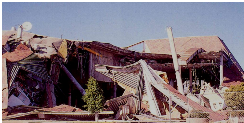
Figura 3: Colapso de um edifício de laje fungiforme causado pela ação sísmica (Northridge, Los Angeles -1994).
