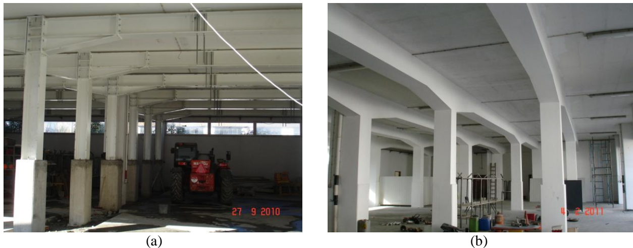
Figura 10: (a) Pórticos em perfis de aço para reforço da laje do teto do piso térreo; (b) vista dos pórticos após a colocação da proteção ao fogo em gesso cartonado.
