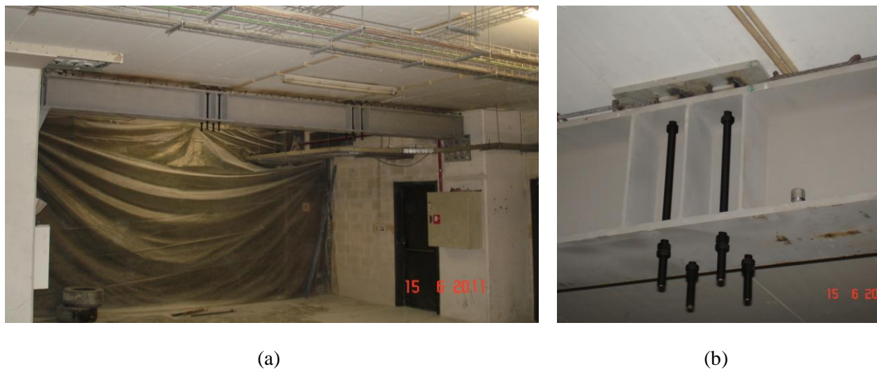
Figura 8: (a) Reforço de uma laje fungiforme com pós-esforço usando uma viga de aço; (b) sistema de imposição dos deslocamentos a terços do vão, com varões roscados e porcas.
