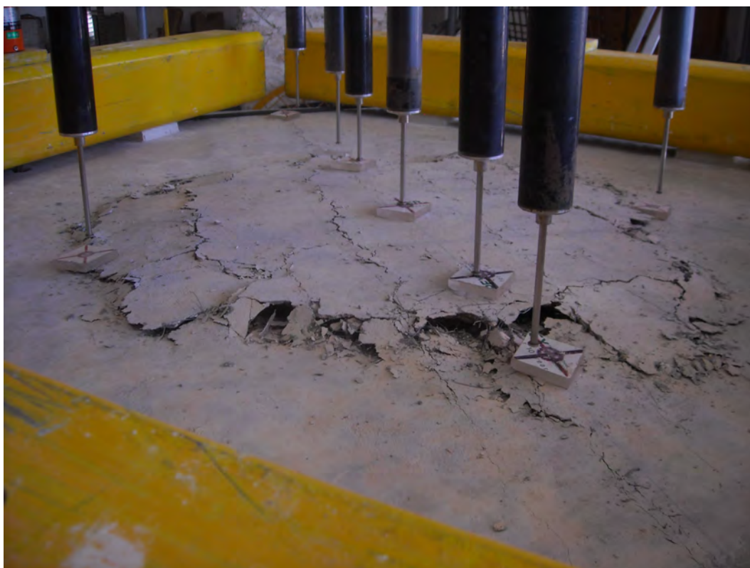
Figura 3.36: Vista geral da rotura por punção do modelo ND4.
