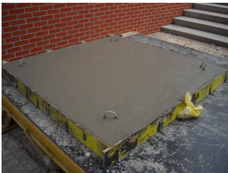
Figura 3.1: Aspecto geral de um modelo de laje após betonagem.
