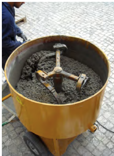
(b) Betoneira a produzir betão.
