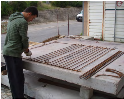
(a) Montagem das armaduras longitudinais.
