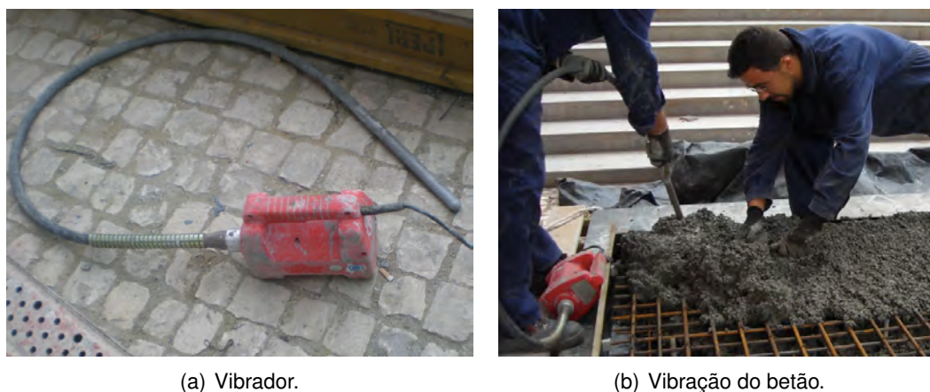
Figura 3.13: Vibrador utilizado na betonagem.
