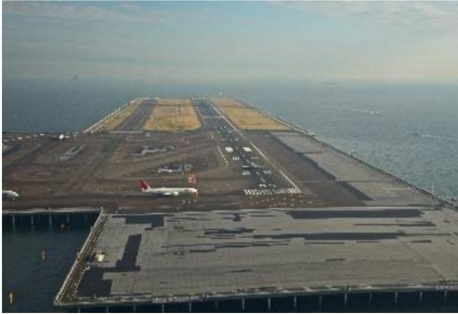
Figura 8. 15 - Nova pista do aeroporto internacional de Tóquio construída sobre o mar
