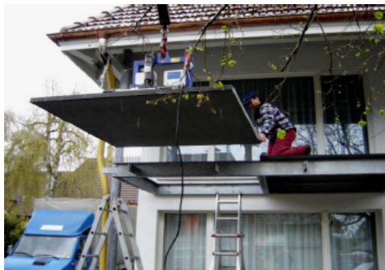
Figura 6. 2 - Instalação de painel de varanda com BCV (cor preta), grupo Vicat
