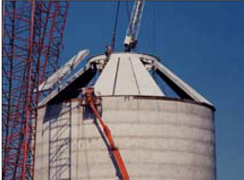
Figura 8. 2 - Instalação da cobertura do silo, Perry e Zakariasen, 2003
