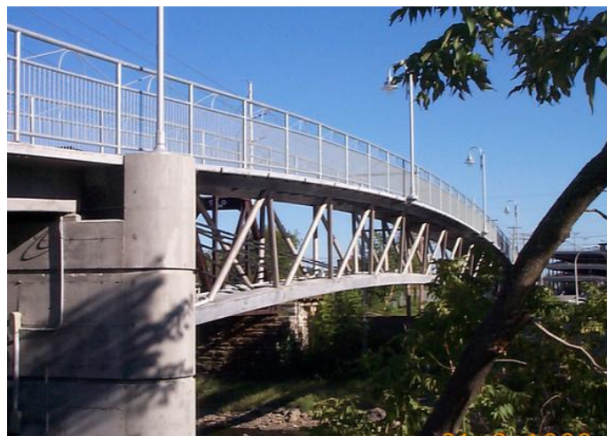
Figura 5. 10 - Ponte de Sherbrooke, Canadá, primeira ponte construída em UHPC, tabuleiro com 3 cm de espessura, sítio da Lafarge
