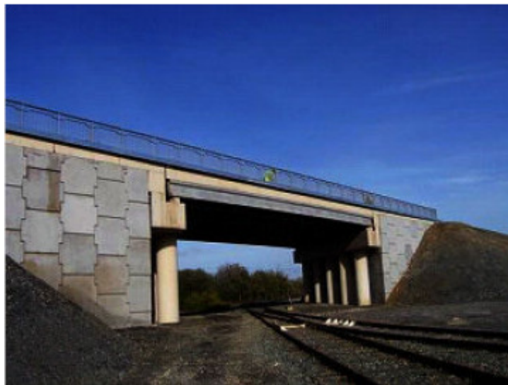
Figura 8.8 - Ponte rodoviária de Saint-Pierre-La-Cour sobre uma linha-férrea, Behloul, Bayard, Resplendino, 2006.
