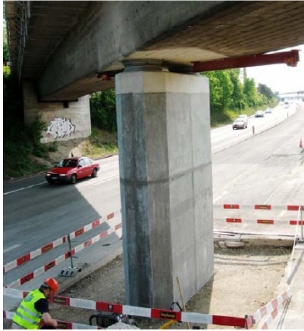
Figura 8. 12 - Pilar reabilitado na Suíça, Brühwiler e Denarié, 2008
