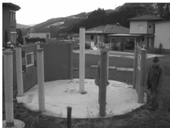
Figura 5. 6 - Construção de pequeno pavilhão com paredes de UHPC de 3 cm de espessura, Monai e Schnabl, 2008
