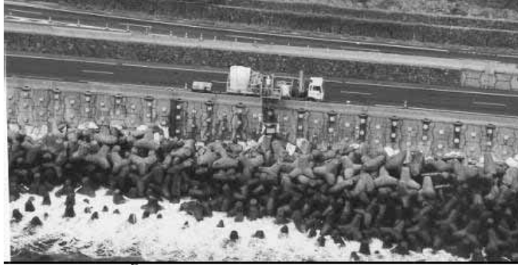
Figura 8. 16 - Tetrapodes constituídos por UHPC na ilha da Reunião, Acker e Behloul, 2004
