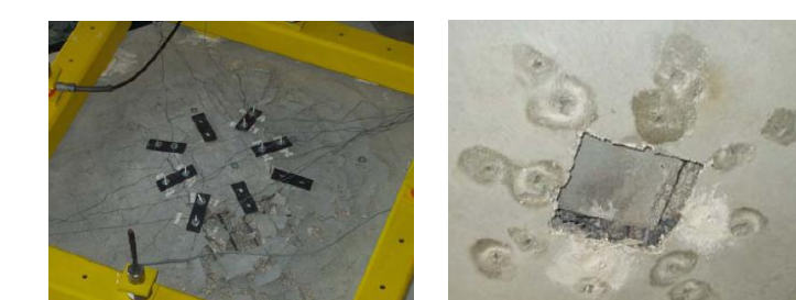
Fig.13 – Vista superior e inferior do modelo M6 após rotura
